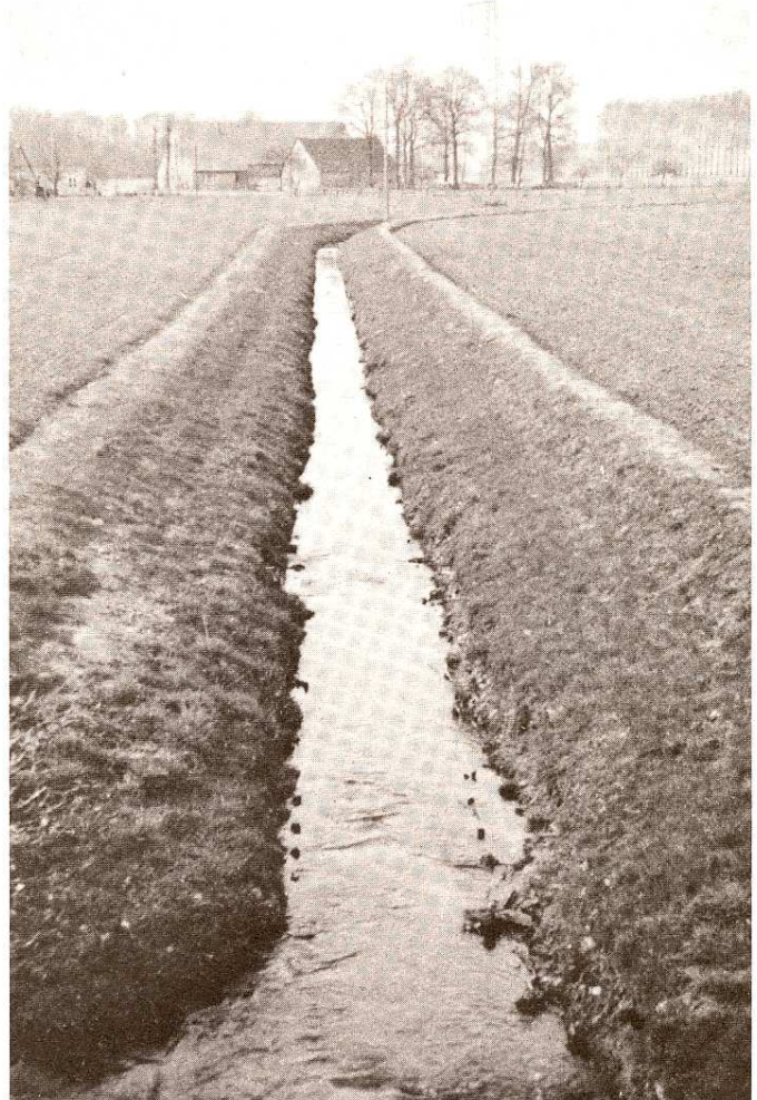
Abb. 2: Ansicht eines ausgebauten Fließgewässers, dessen einförmige Strukturen den Fortfall der Lebensmöglichkeiten vieler Arten zur Folge haben (Obere Hase, ca. 2 km unterhalb Abb. 1).
